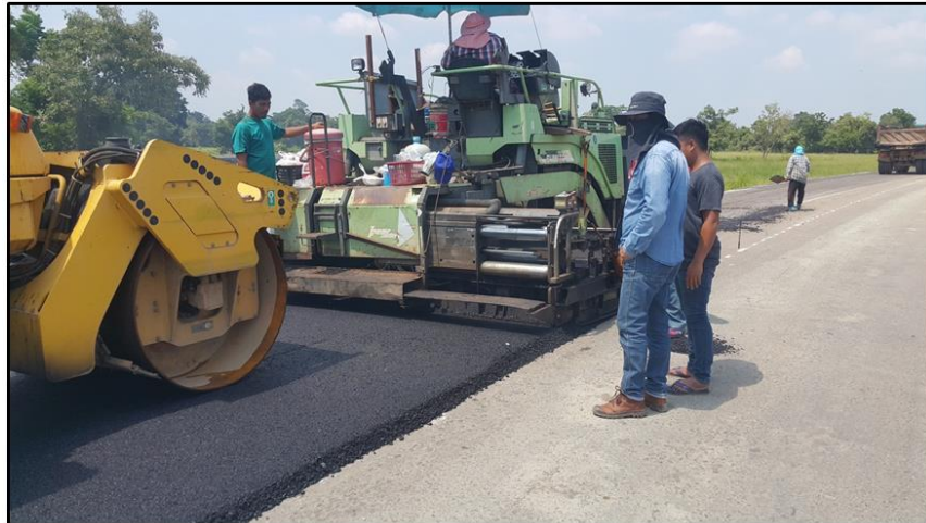
บดทับชั้นที่ปูผิวทางแอสฟัลต์คอนกรีต
