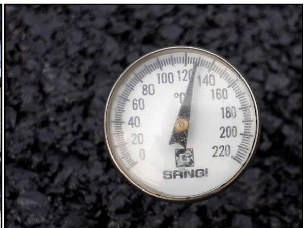
ตรวจสอบอุณหภูมิขณะปูแอสฟัลต์คอนกรีต ต้องอยู่ระหว่าง 120°C ถึง 150°C
