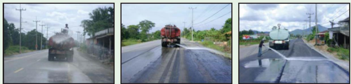
ฉีดล้างทำความสะอาด ทิ้งให้แห้งก่อนปูแอสฟัลต์คอนกรีต
