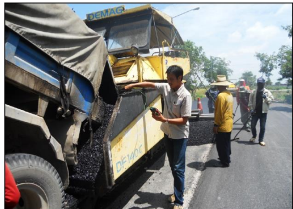
การตรวจสอบอุณหภูมิส่วนผสมแอสฟัลต์คอนกรีตที่โรงงานผสมและที่สถานที่ก่อสร้าง
