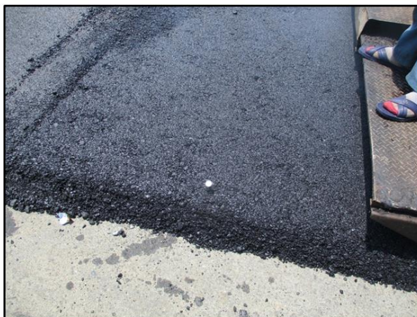
ตรวจสอบอุณหภูมิขณะปูแอสฟัลต์คอนกรีต ต้องอยู่ระหว่าง 120°C ถึง 150°C
